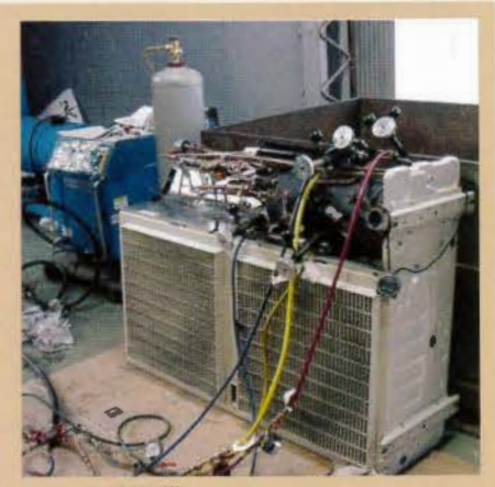
フロン回収設備
