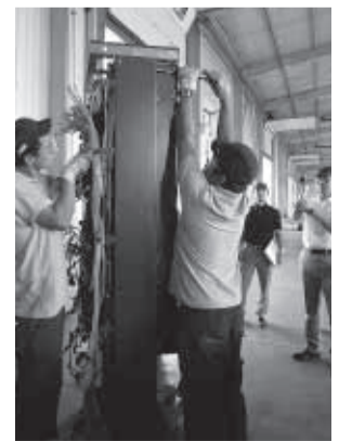
トルコでの電子機器類解体状況の調査(2012年7月)
