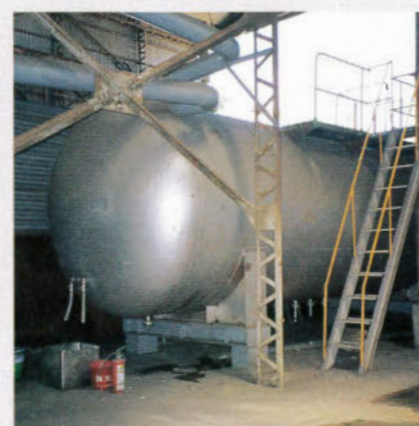
防火用雨水採集タンク
