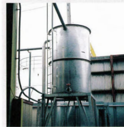
トイレ使用雨水採集タンク
