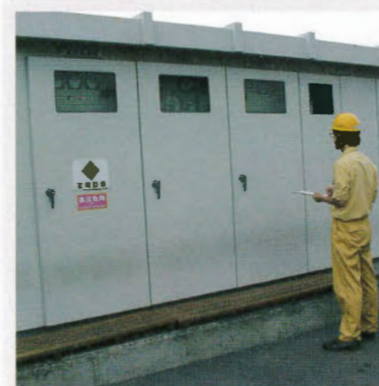
電気使用量の確認
