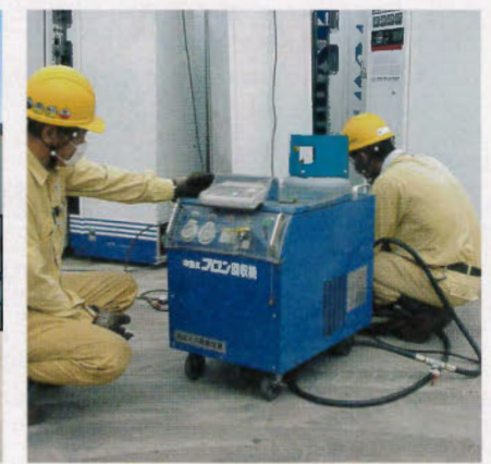
自動販売機からのフロン回収
