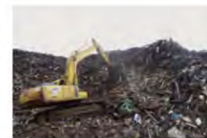
重機による切り出し作業(宮古市)
